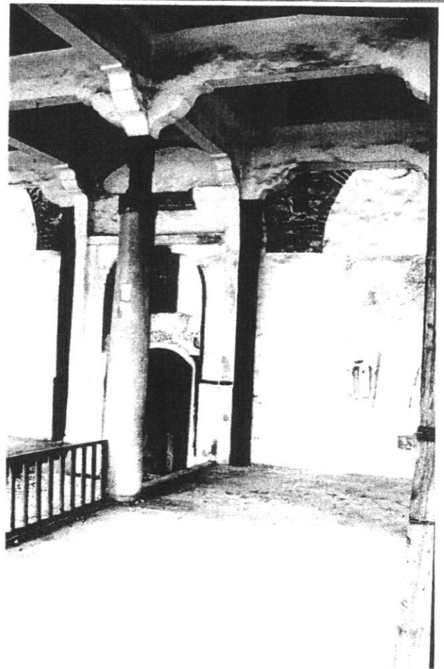
Забележки: Изглед от север към входа
