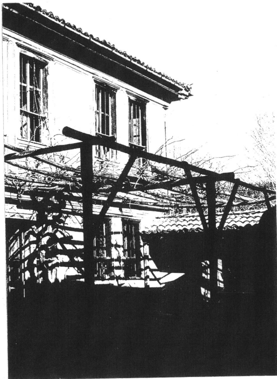
7. Фрагмент от южната фасада.
